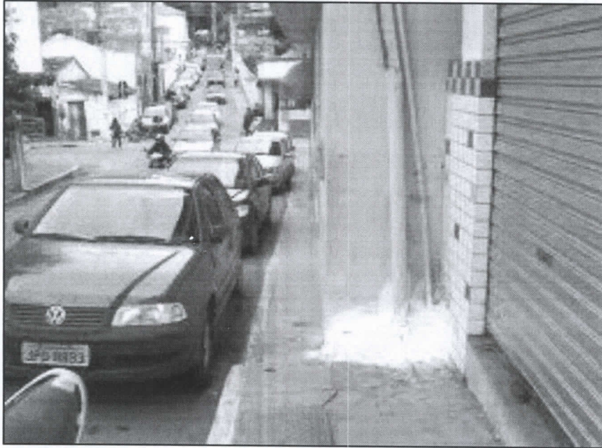
Figura 57: calçada sem largura mínima
