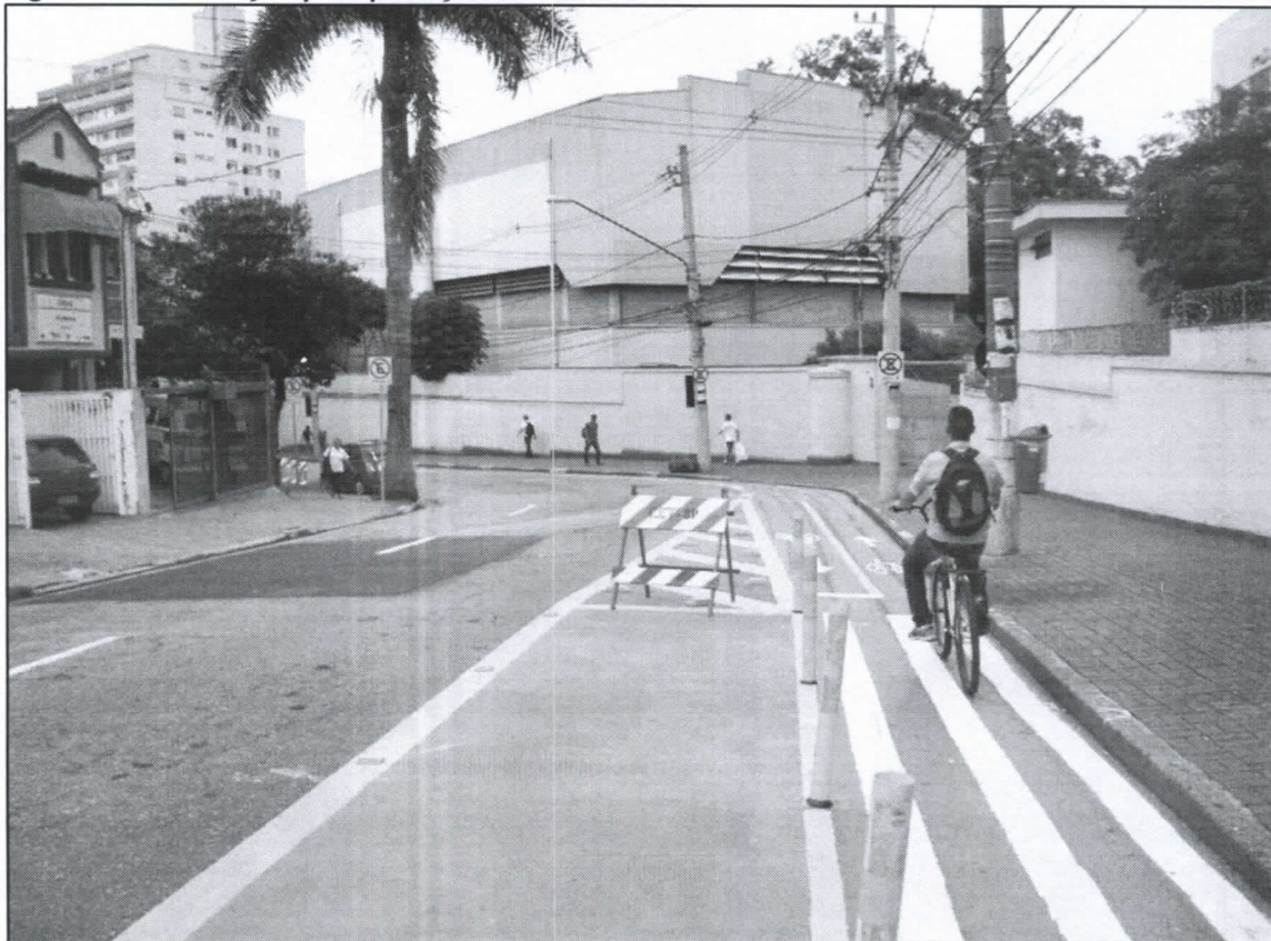
Figura 51: Sinalização para proteção de ciclofaixa
