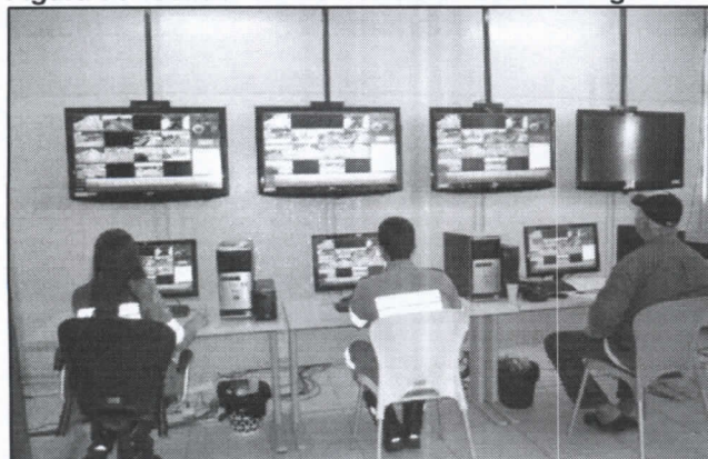
Figura 76: Central de Monitoramento de Tráfego
